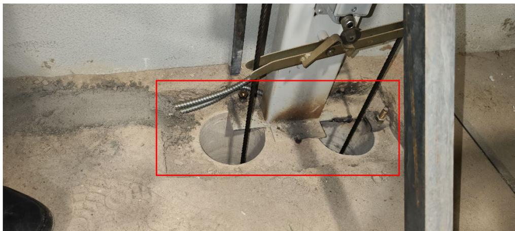
5.3.3.11 Вокруг отверстий над шахтой лифта должны быть устроены бортики, выступающие не менее чем на 50 мм над уровнем плиты перекрытия или пола. Минимальное расстояние от края отверстия до проходящих через него подвижных элементов должно быть не менее 10 мм.
