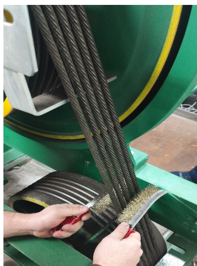
Предварительная очистка поверхности тяговых канатов от загрязнений
