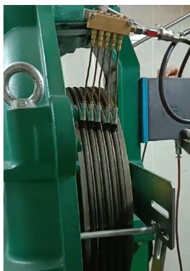
Нанесение смазки Gustav Wolf T-86 на тяговые канаты с помощью автоматического устройства
