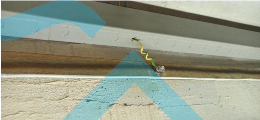
15. Подвесной кабель деформирован, имеет повреждение
