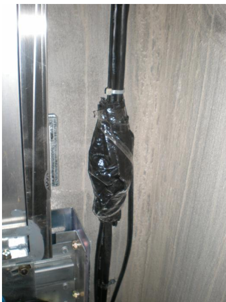
Этажный сетевой кабель для STEP блока управления
